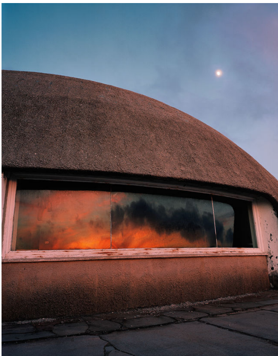
La façade de la Cupola 1
